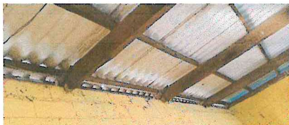
Foto 9: Sustitución de soporte de madera por metal en un salón de clases.
