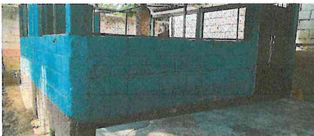
Foto 3: Pintura en muros exteriores de cocina
