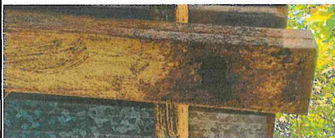
Foto 5: Mantenimiento a estructura de soporte de metal (lijado, pintura)
