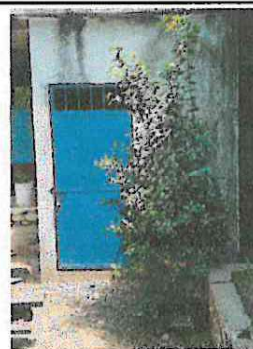
Foto 4: pintura en muros de servicios sanitarios
