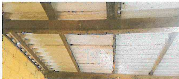
Foto 8: Sustitución de lámina ananalada o duralita por lámina troquelada.
