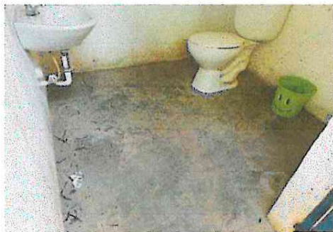
Foto 7: Sustitución de Piso de concreto por piso de (granito, cerámico antideslizante en servicios sanitarios)
