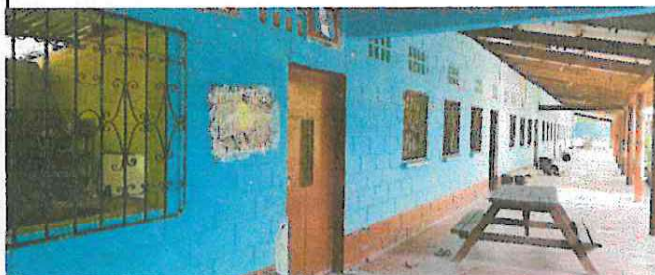
Foto 2: Pintura de muros exteriores en salones.
