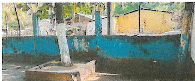
Foto 1: Reparación y pintura de muro perimetral que limita con la calle principal.
